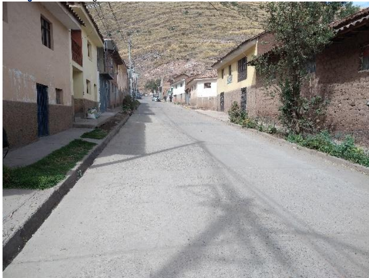
Imagen N° 57: Fotografía de Av. Daniel Estrada Pérez en estado de conservación malo
