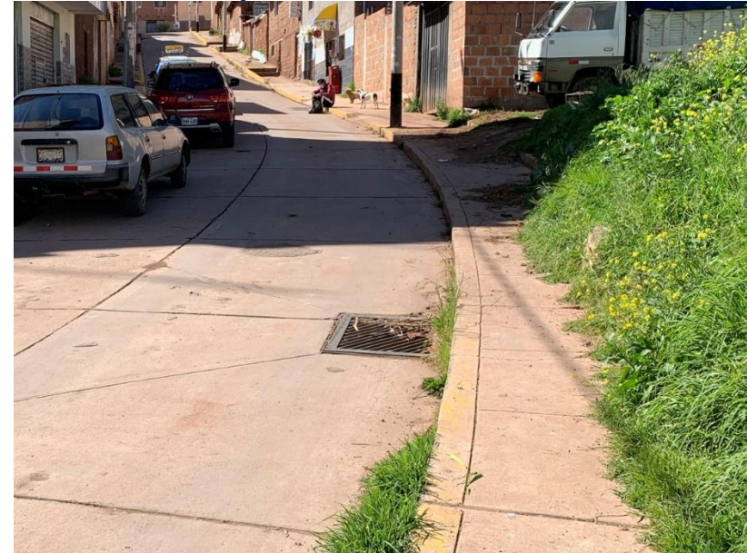
Imagen N° 97: Canal cerrado en la Ca. S/N 02
