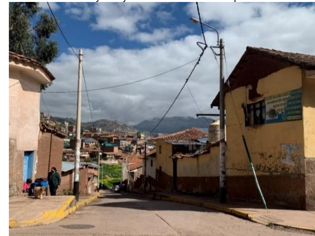
Imagen N° 90: Poste de alumbrado público instalado dentro de la acera disminuyendo y obstaculizando el tránsito peatonal
