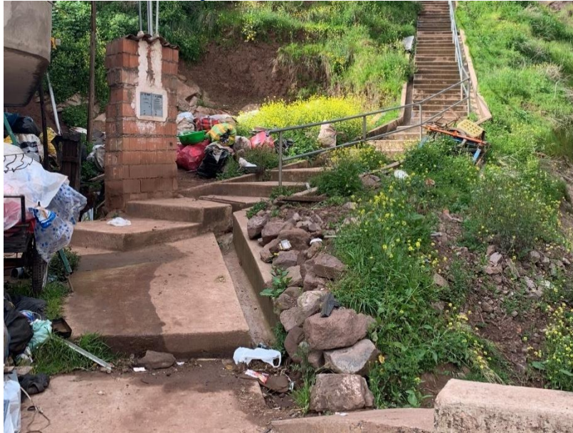
Imagen N° 96: Canal abierto en la Ca. 1
